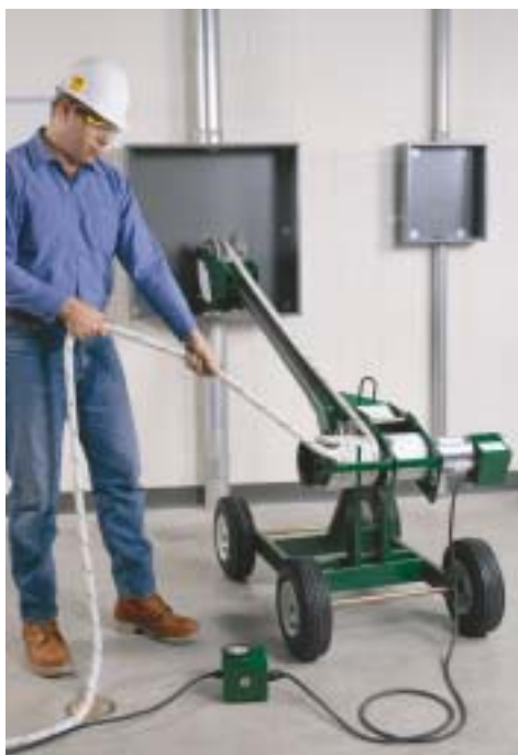
Поднимающаяся тяга с устройством Ultra Tugger, установленным на передвижной тележке.
