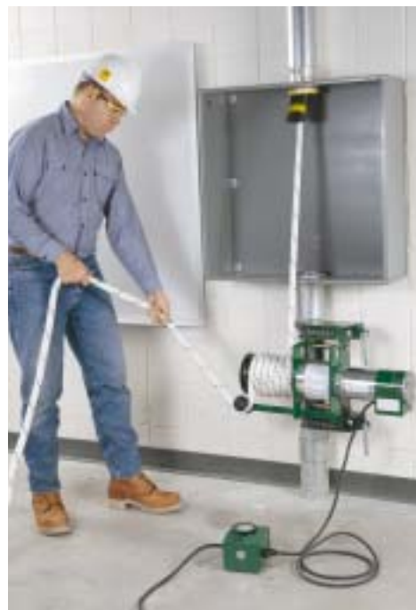
Спускающаяся тяга с платформой на цепи, закрепленной на трубопроводе.
